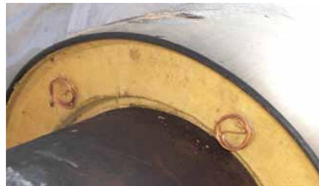
Die Kunststoffmantelrohre bestehen aus einem inneren Mediumrohr aus Stahl, einem Polyurethan-Hartschaumstoff (PUR) für die Wärmedämmung und einem robusten Mantelrohr aus Polyethylen (PE).
